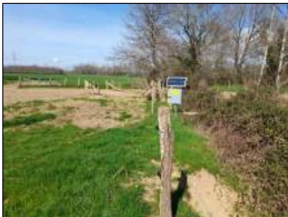
Figure 1 : Clôtures électriques via un poste solaire sur le Rhodon à Perreux
