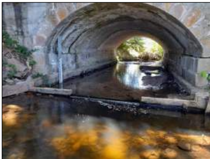
Figure 153 : Seuil à échancrure sur la Teyssonne à Changy
