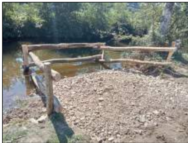
Figure 3 : Descente aménagée sur le Reins à St Jean la Bussière
