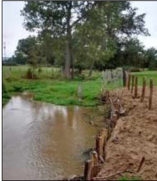
Figure 12 : Installation d'un peigne sur le Fillerin à Saint Romain la Motte
