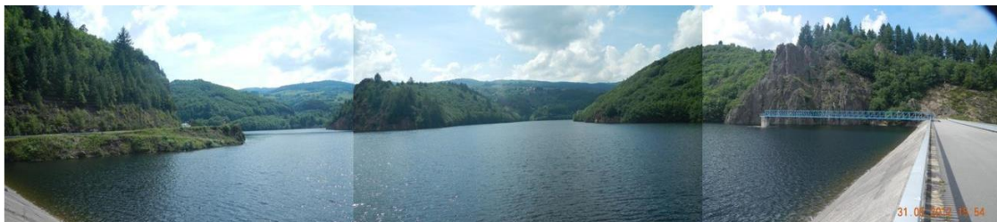
Figure 3 : Photo de la retenue du barrage du ROUCHAIN (source ISL)
