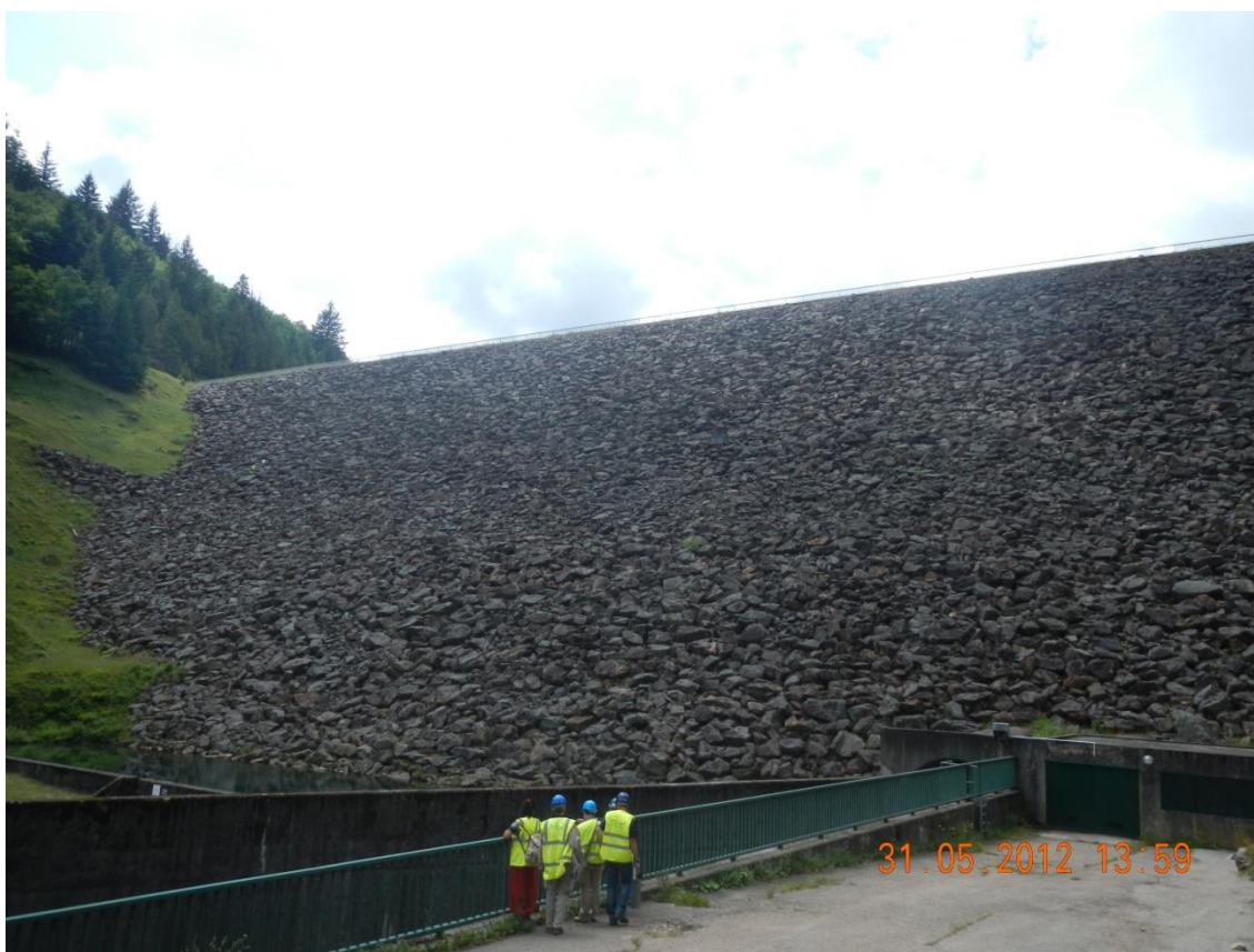
Figure 4 : Photo du barrage du ROUCHAIN depuis le pied aval (source ISL)
